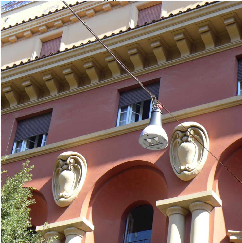
Edificio in Via Taro 35 a Roma, del 1928
