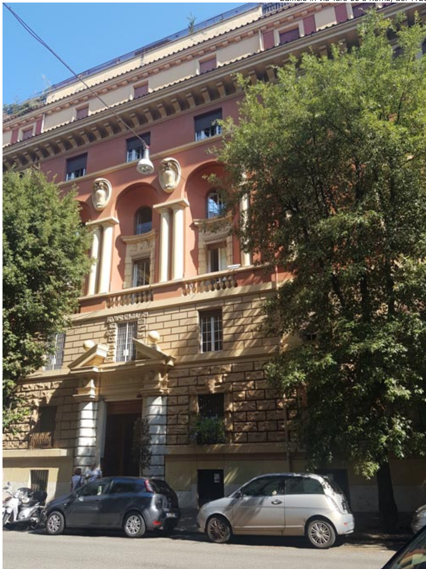
Edificio in via Taro 35 a Roma, del 1928
