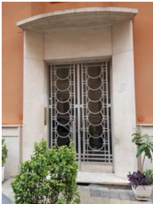
Particolari degli ingressi delle palazzine in via Salaria 298 e 302 a Roma, del 1934
