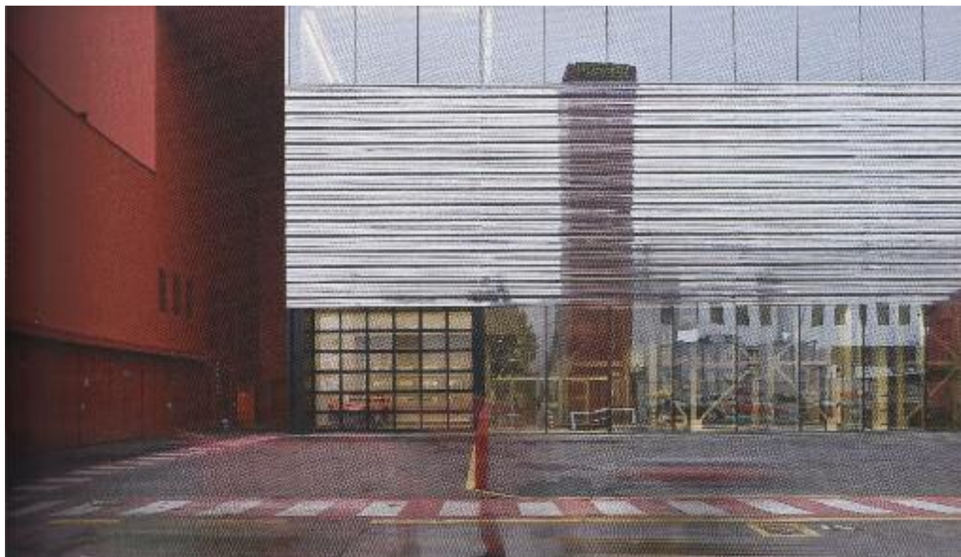
Stazione di montaggio dello Stabilimento Ferrari a Maranello (MO) del 2009, progetto di Jean Nouvel.
